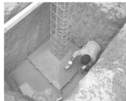
Armado de base aislada
