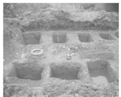
Armado de batería de bases
