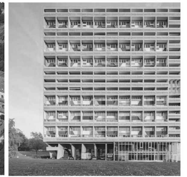
Unidad Habitacional de Marsella, Le Corbusier, 1947-1952
