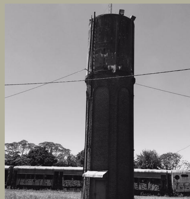
Imagen 24 Tanque de agua
