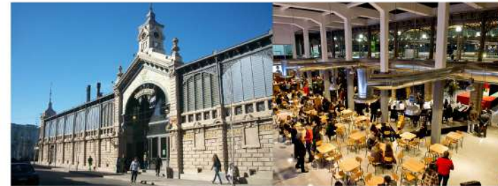
Recuperación del barrio - Rehabilitación del mercado - regeneración urbana y social. Modernidad en concordancia con el pasado - Productos gourmet y directo del productor.
