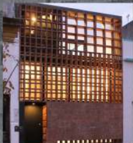
Casa de ladrillos Ventura Virzi
