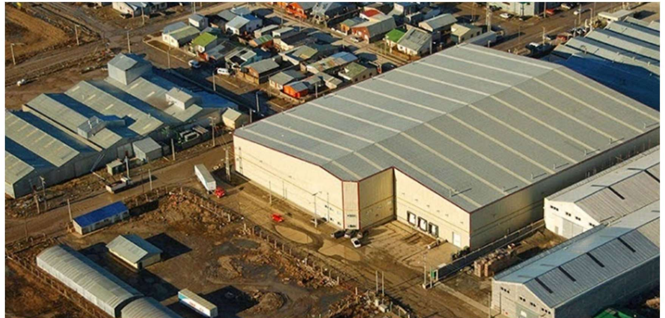
Imagen aérea de un sector del Bº Industrial
