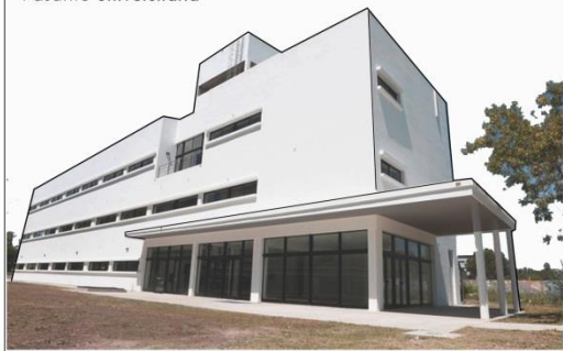
Bloque "C", FaHCE
