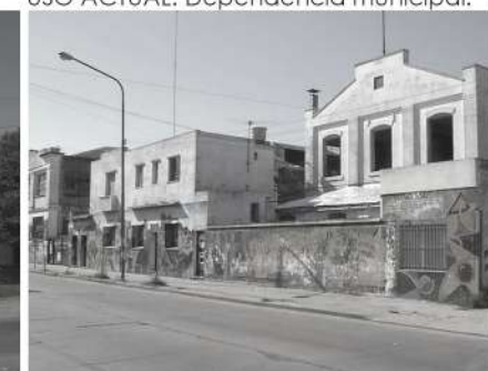
Coop. Arg. Textil de Trabajo Ltd- 1911/63 PROP.: Municipalidad de Berisso - ESTILO Y TIPO: Arquitectura industrial - USO ACTUAL: Dependencia municipal.
