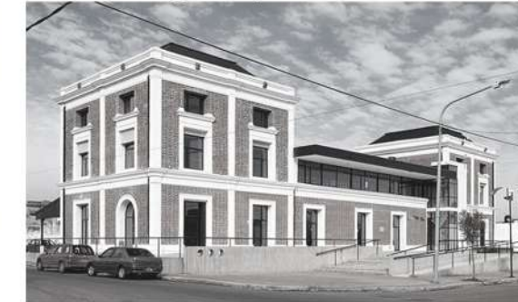
Estación Ensenada 1887 - Centro cultural PROPIETARIO: Municipalidad de Ensenada ESTILO Y TIPO: Ingles - Arquitectura ferroviaria
