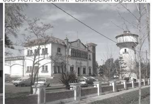
Planta potabilizadora, almacenadora - 1947 PROP.: Provincia - AGUAS BONAERENSES S.A. ESTILO Y TIPO: Neocolonial español USO ACT: Of. admin. - Distribución agua pot.
