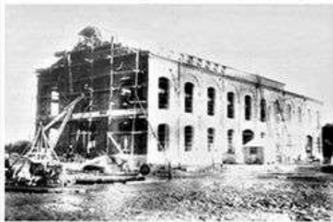
Construcción de la Usina
