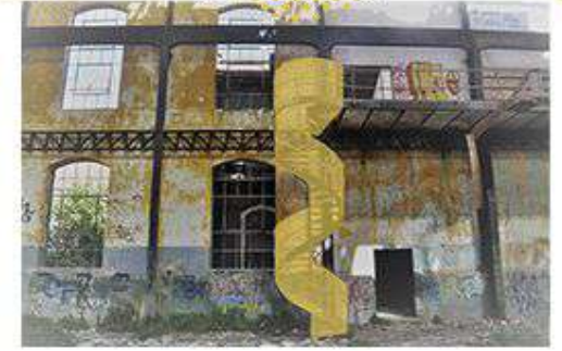
Escaleras y plataformas
