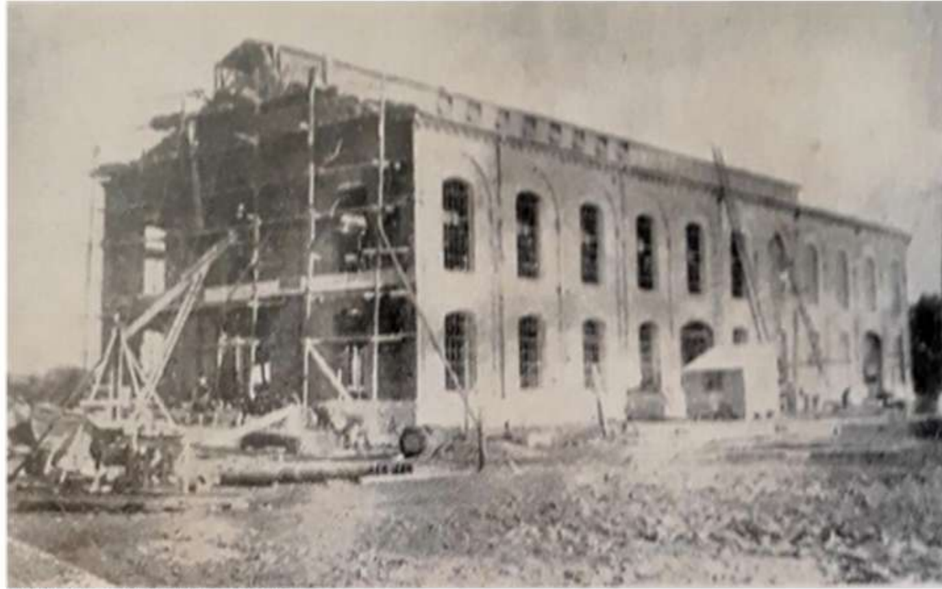
USINA EN CONSTRUCCION 1928
