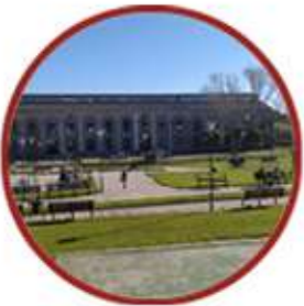
1- Usina y plaza
