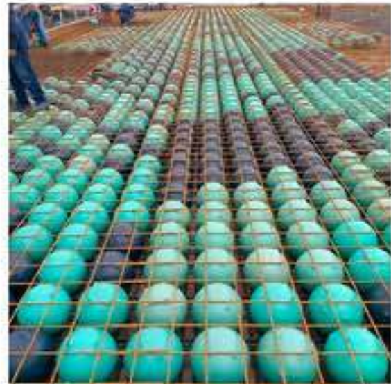
Detalle armado pre hormigonado
