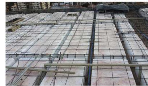
Cables Tensores en estructura de losa alivianada por casetonado
