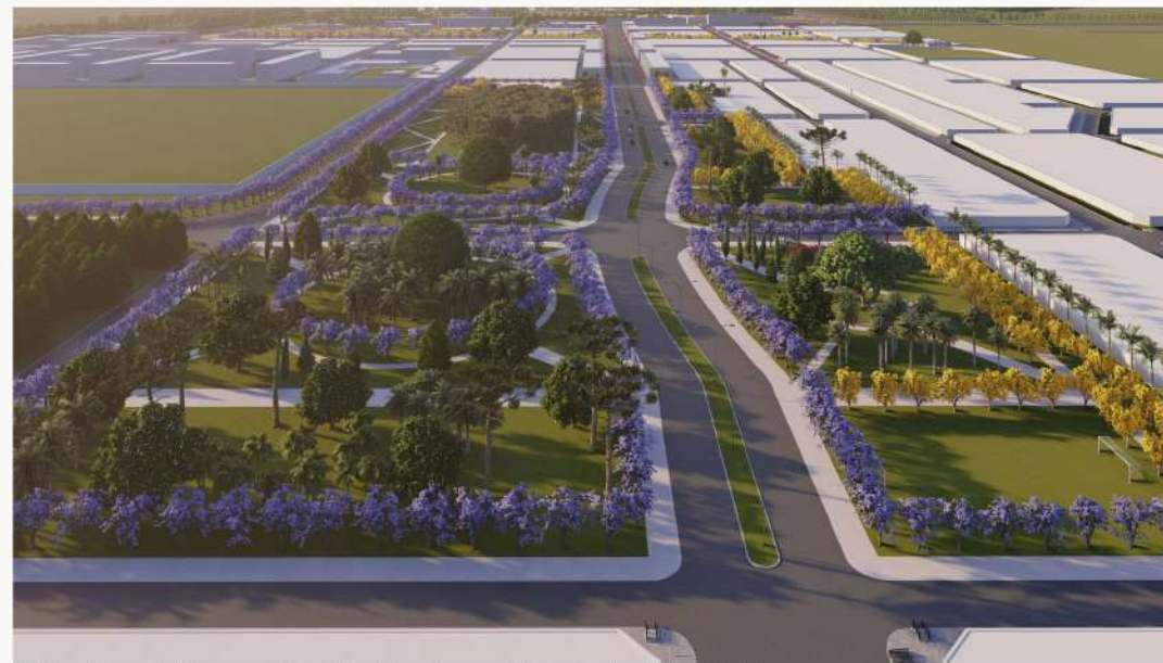
Vista aérea del Parque San Martín y la avenida principal (av. 125)
