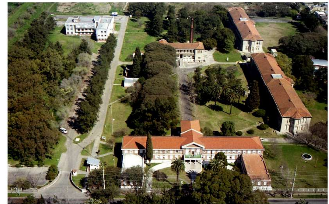
Vista aérea del predio hospitalario (área de intervención arquitectónica)
