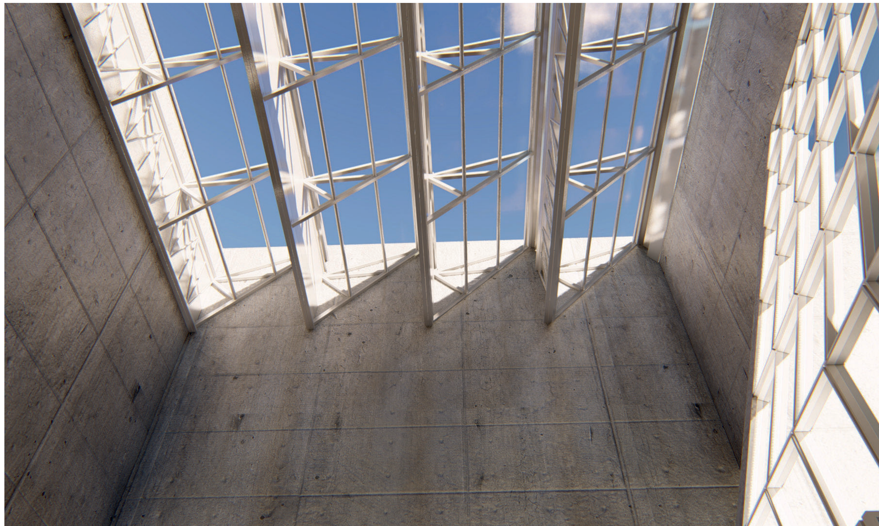
CUBIERTA VIDRIADA DE HALL DE ACCESO
