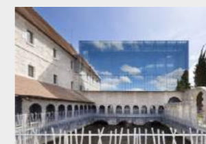
Ampliación de la escuela musical Louviers Opus 5
