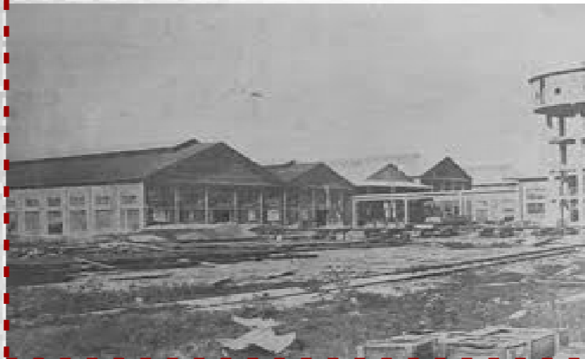
TALLERES FERROVIARIOS GAMBIER
