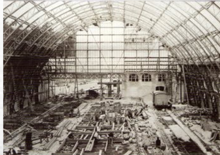
2-CONSTRUCCIÓN ESTACIÓN LA PLATA NAVE DE TRENES
