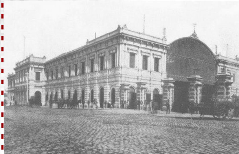
ESTACIÓN 19 DE NOVIEMBRE
