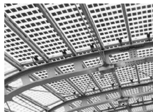
Detalle Cubierta Estación Porta Susa Torino. Italia
