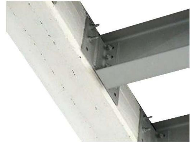
IMAGEN REFERENCIA. Fijación de una viga de acero sobre una viga de hormigón
