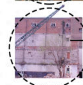
MARCAS DE EDIFICIO DERRIBADO
