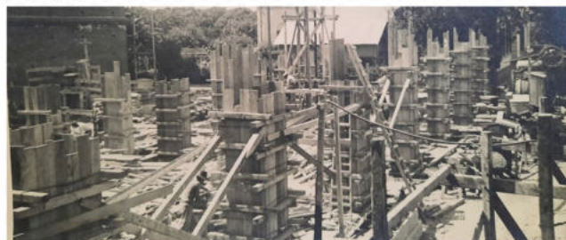
CONSTRUCCIÓN DE COLUMNAS DE H°A°
