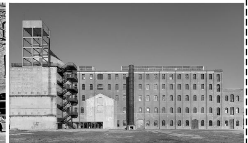
Refuncionalización ex Molino Marconetti
