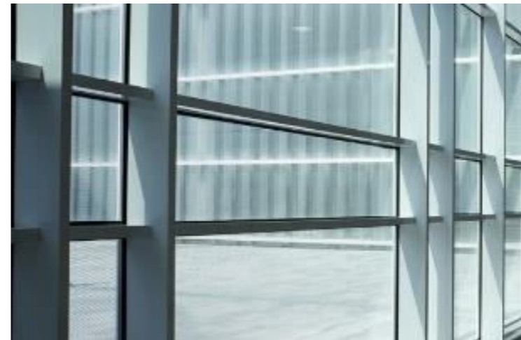
Envolvente-Doble piel paneles micro perforados
