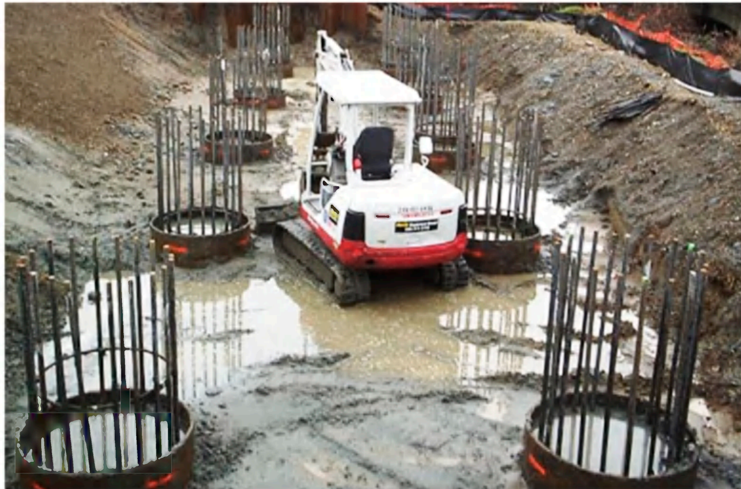
IMAGENES REPRESENTATIVAS DE PILOTINES ENCAMISADOS
