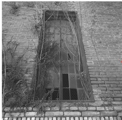
Carpinterías metálicas de doble hoja.
