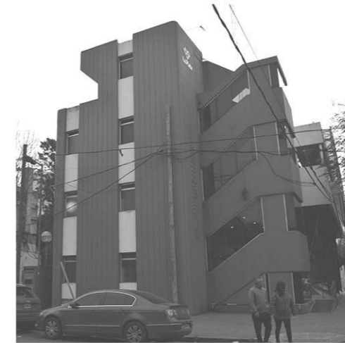
Edificio de Control Ciudadano calle 20 y 50
