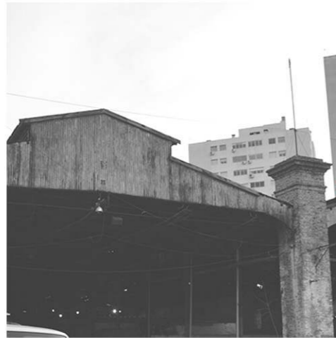
Unión de cubierta y pilar de ladrillo macizo.
