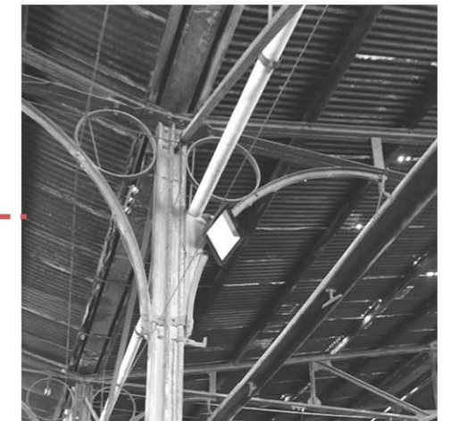
Unión de rieles y cabriadas. Recorrido de cañería pluvial.
