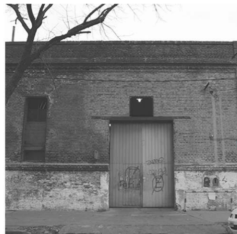
Muro ext. de ladrillo macizo visto. Intervenciones sobre la fachada.
