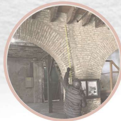
HALL ACCESO BARRACA 2
