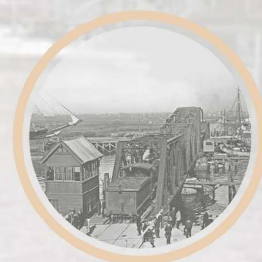
PUENTE LEVADIZO BARRACA PEÑA
