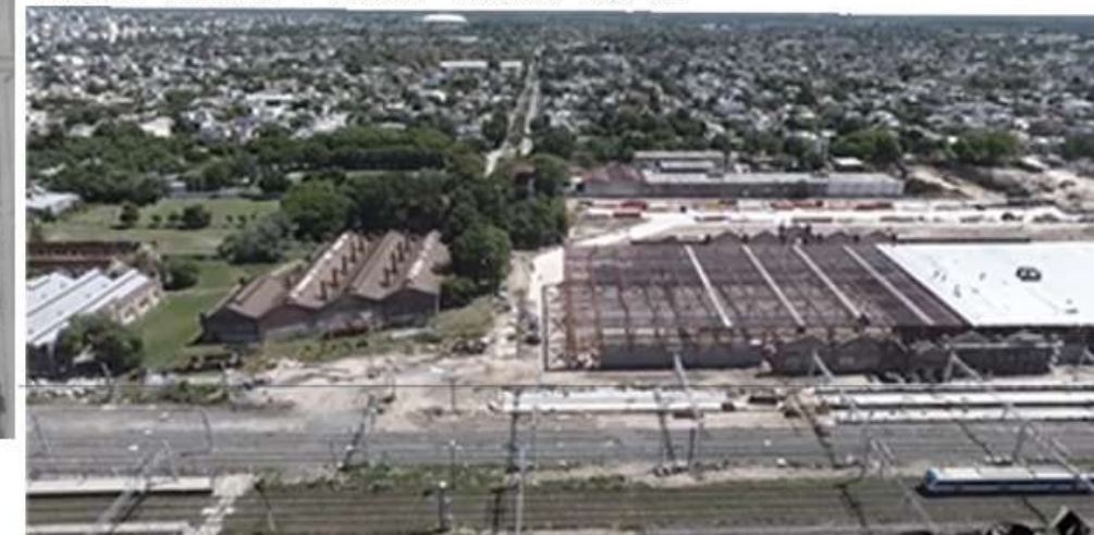
3● Visual interior hacia el centro de Tolosa
