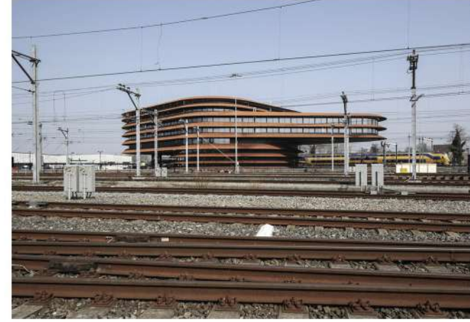
Centro de Control de Trenes Utrecht
