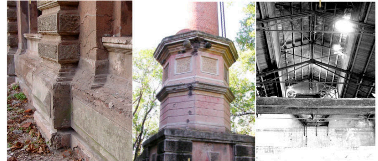
FISURAS DESPRENDIMIENTOS Y DEGRADACION DE LOS MUROS ATAQUE DE PLAGAS MADERA DEL CIELORRASOS
