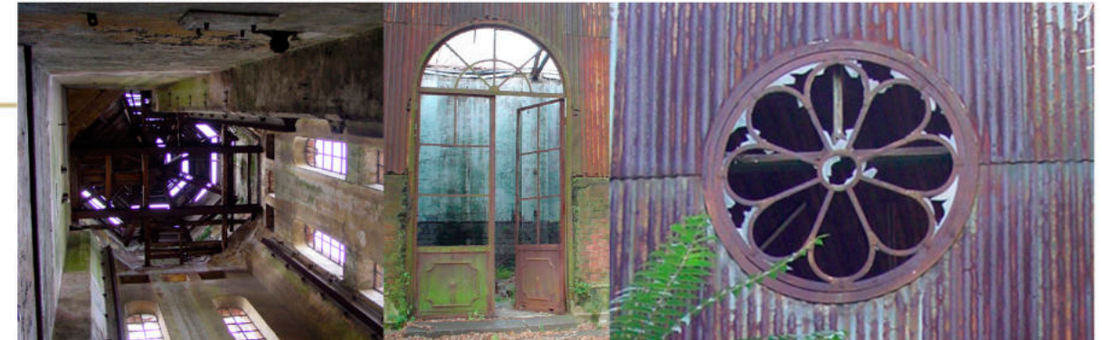
AUSENCIA POR EXTRACCION DE CERAMICOS DEL SOLADO DE LA SALA DE MAQUINAS Y DE LA SALA DE CALOR AUSENCIA DE VIDRIOS Y DIVISIONES CORROSION Y DEGRADACION
