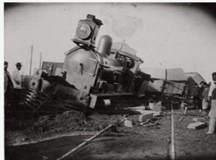
Accidente y descarrilamiento por falta de mantenimiento de las vías en General Belgrano, ferrocarril Belgrano Sur.
