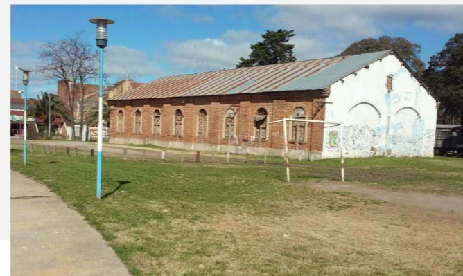
B GALPON DE LOCOMOTORAS ACTUALIDAD
