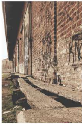
Estado de conservación de las fachadas y deterioro de las juntas en los muros
