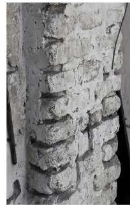
Estado de conservación de las fachadas y deterioro de las juntas en los muros
