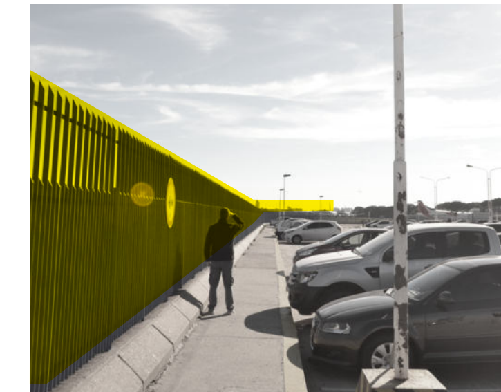
Separación entre estacionamiento y pista con rejas
