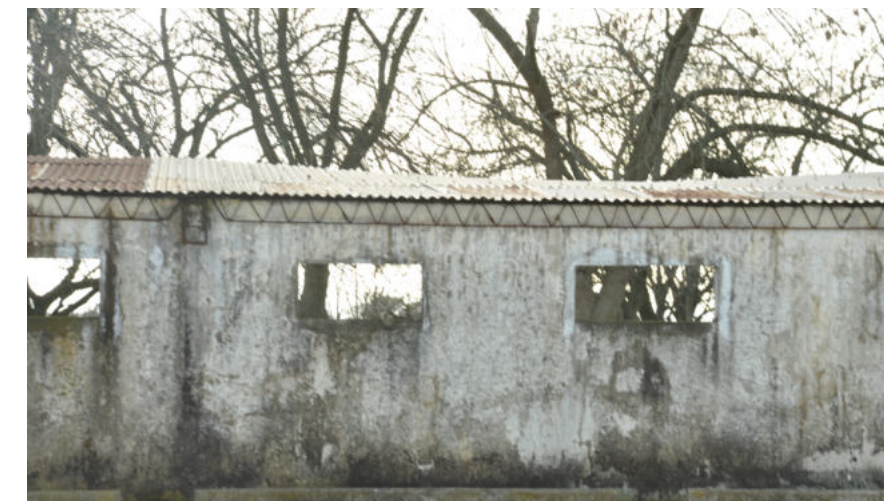
Estado actual de las instalaciones del predio
