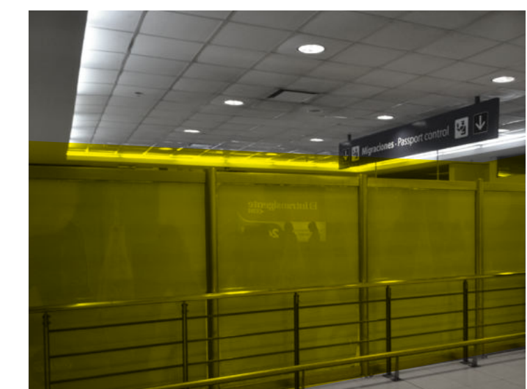
Separación entre migraciones y hall con vidrio esmerilado
