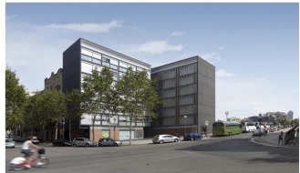
Vivienda social. Balcells Blesa Referente en cuanto a materialidades, fachada
