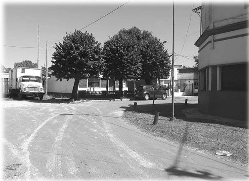
Calles internas del sector, donde se puede ver la falta de pavimento, cordón cuneta y veredas bien definidas, las construcciones existentes no superan los dos niveles.
