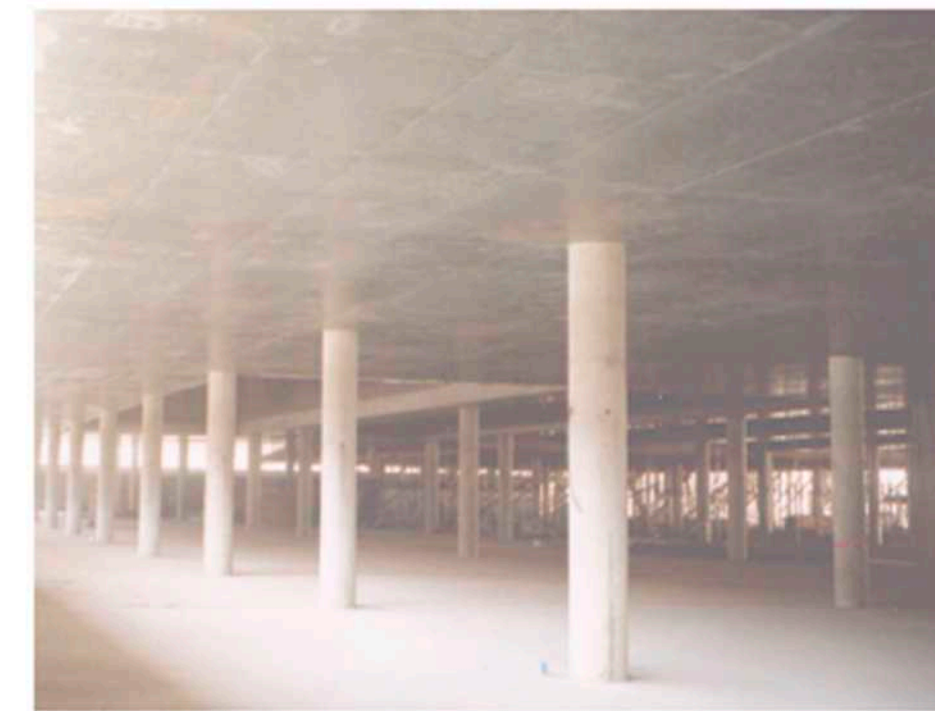
Ejemplo de losa aligerada con casetona' Village Cinemas Recoleta. Nivel + (hoy modificado Recoleta M...)
