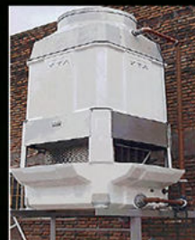
TORRE DE ENFRIAMIENTO
