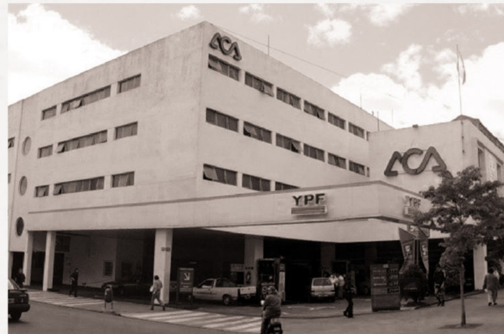
LA SUCURSAL DE AUTOMÓVIL CLUB ARGENTINO UBICADA EN CALLES 51 Y 9 MARCA UNA TENDENCIA EN CUANTO A TIPOLOGÍA DE CONSTRUCCIÓN DE ESTA ENTIDAD (ACA). SU DISEÑO ES CLARAMENTE FUNCIONAL Y QUIZÁS AL EXTREMO DE RESULTAR POCO RELEVANTE
