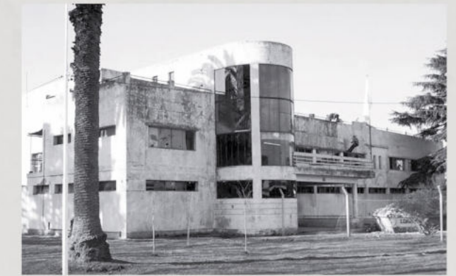
Estado del edificio luego de décadas de abandono y
