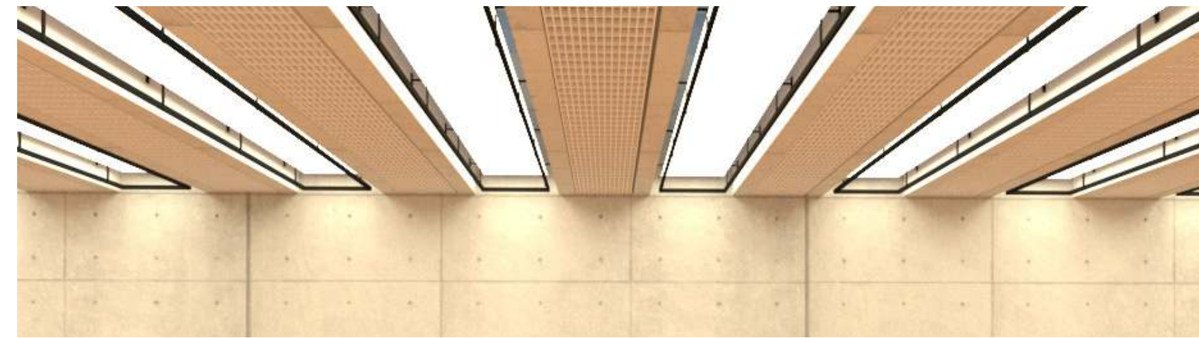
1. vidrio doble DVH con vidrio esmerilado templado; 2. parasoles metalicos regulables y abatibles para mantenimiento; 3. carpintería de aluminio prepintado blanco; 4. tamizador de tela con estructura metalica; 5. techo suspendido de paneles enrejados de acero acabado con pintura esmalte blanco; 6. ducto de aire; 7. luminaria led
