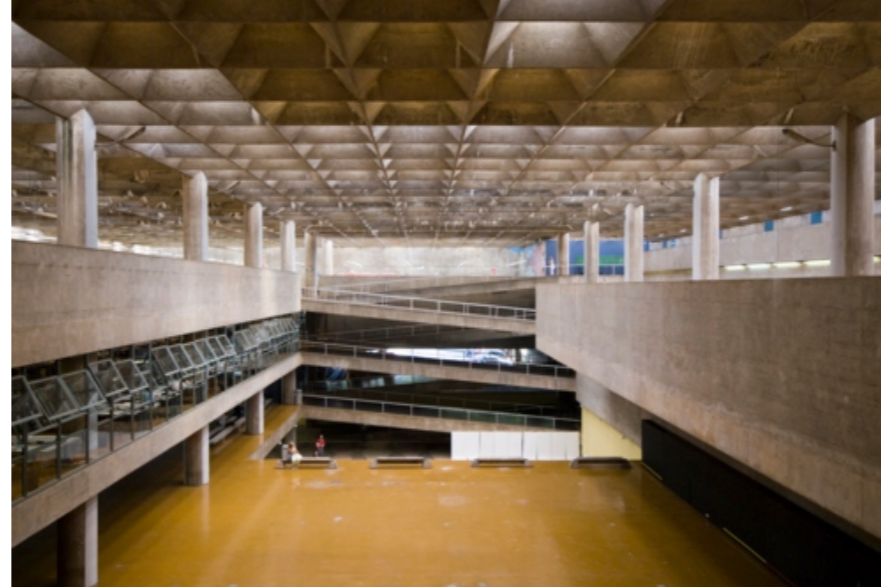
FACULTAD DE ARQUITECTURA, BRASIL VILANOVA ARTIGAS
