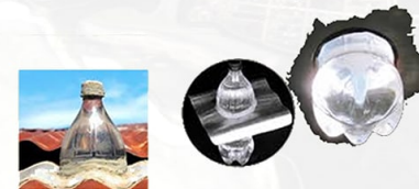
Botellas plásticas como focos en el acceso a la vivienda botella+ agua+ 10ml de cloro=foco
