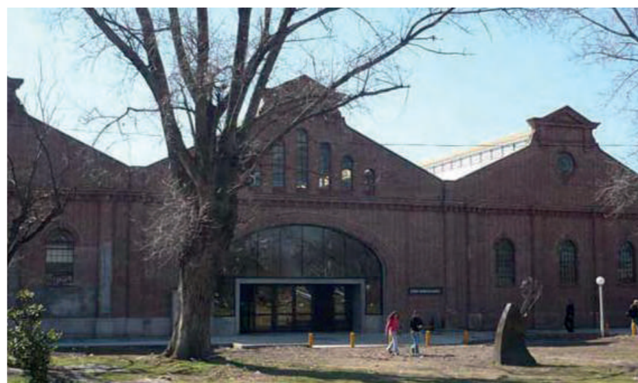
ARRIBA: Abandono de espacios industriales. MEDIO: Talleres en desuso. ABAJO: Espacios ferroviarios refuncionalizados.
