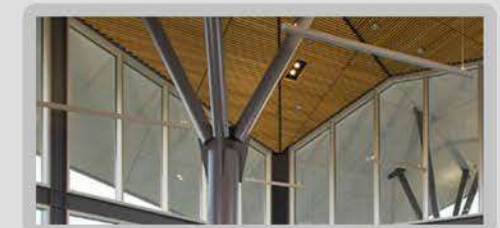
Ramificación de columna metálica
