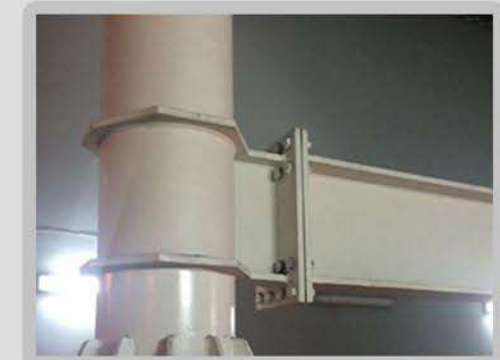
Unión columna y viga de entrepiso
