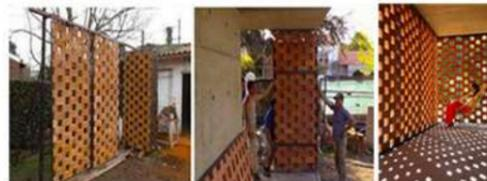
El Cerramiento murario en toda la cara de los consultorios esta conformado por paneles de 1m x 3m, compuesto por ladrillos de comun tipo panderete (nido de abeja), permite permeabilidad luminica y visual.
