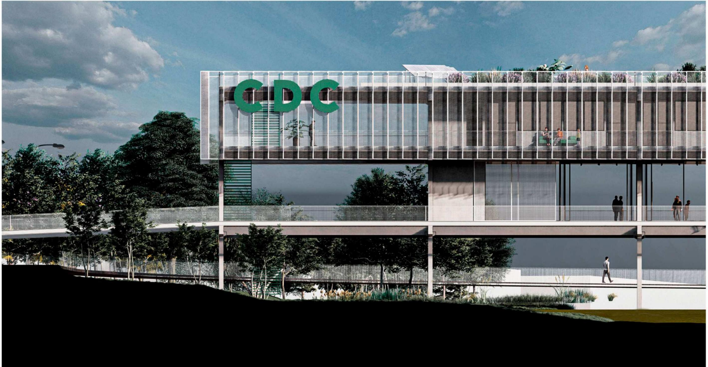
La propuesta de un edificio de carácter público y abierto a la comunidad, conlleva la decisión de utilizar materiales que requieran el mínimo mantenimiento. Por este motivo para los cerramientos traslúcidos se utilizó **policarbonato compacto antivandálico (DVP)**, envolvente y cerramientos de **malla metálica de hierro cuadrada**, la misma funciona como seguridad pero permeable a la luz. Los muros son de **construcción en seco**, rápida ejecución y fácil mantenimiento.
