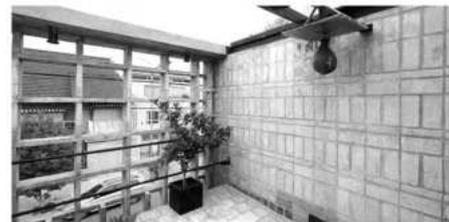
La casa de ladrillo en Argentina utiliza materiales tradicionales con alta aislación térmica. Su diseño incluye un sistema de muro parasol, basado en Wladimiro Acosta, que combina losa visera y parantes para regular la entrada de sol y crear sombra en verano. Este sistema genera un efecto de aire sobre las paredes, denominado Aura Térmica, que mantiene un ambiente fresco y cómodo, fusionando funcionalidad y sostenibilidad.
