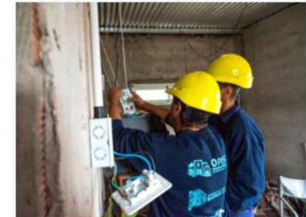
San Nicolás: Avanzan los trabajos de conexiones intradomiciliarias en el barrio Cavalli
