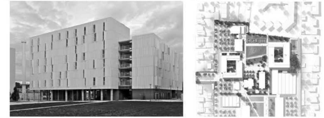
OLIMPIA de GOUGES , Toulouse, PPA Arquitectos (2017)
