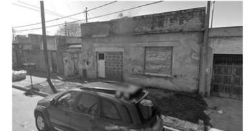
LOTE 15 Subdividido. En deterioro.
