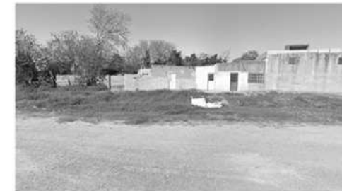
LOTE 2 Subdividido. Autoconstrucción.
