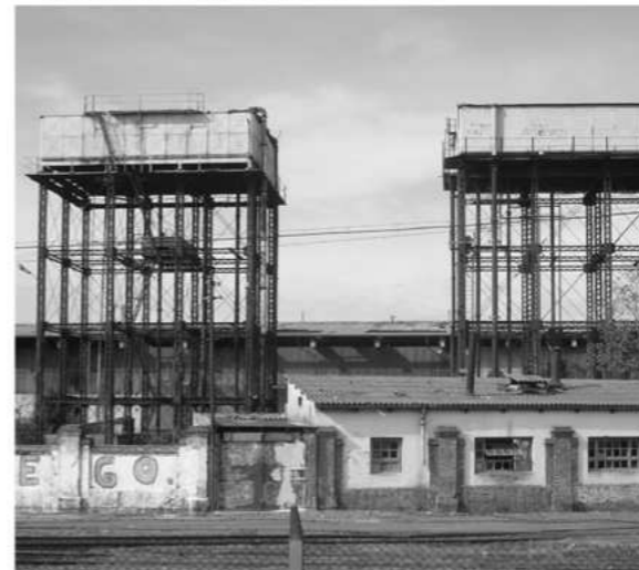
TANQUES DE AGUA RDE
