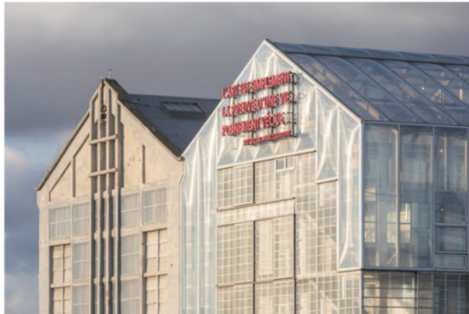
LACATON Y VASSAL. FRAC DUNKERQUE
