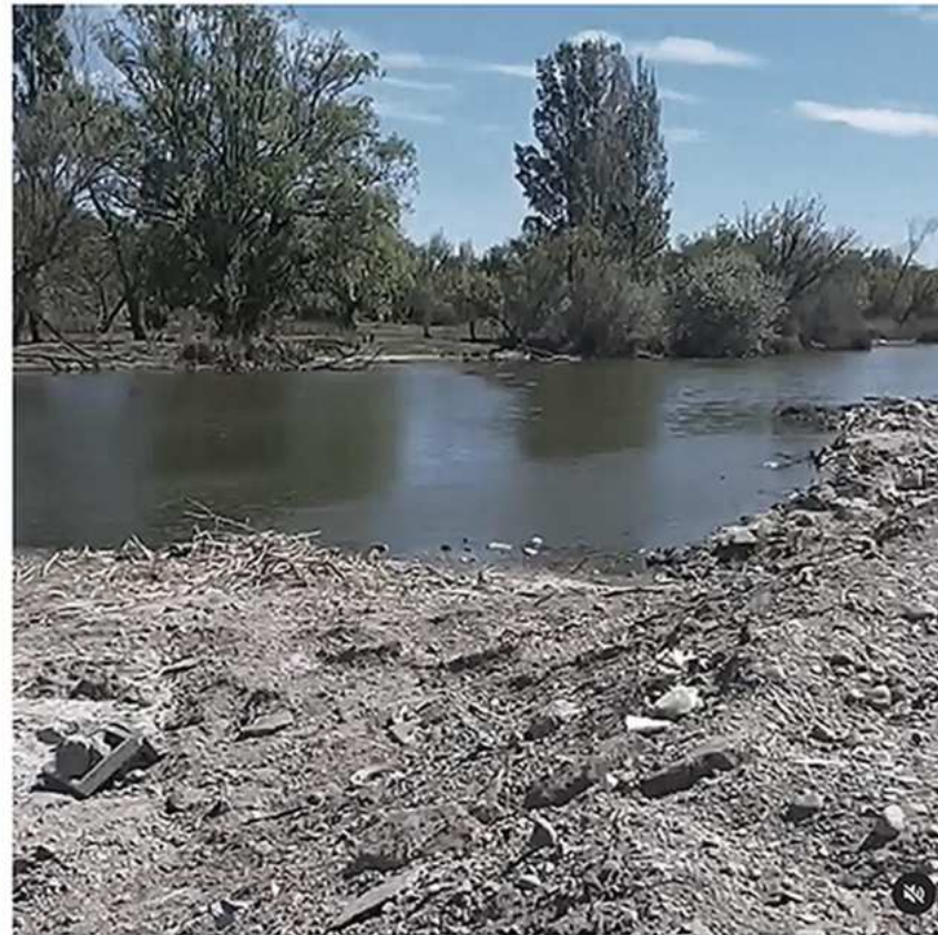
2) ACUMULACION DE SEDIMENTOS Y ESCOMBROS
