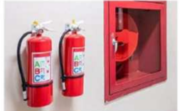
Boca de incendio con extintores tipo ABC.
