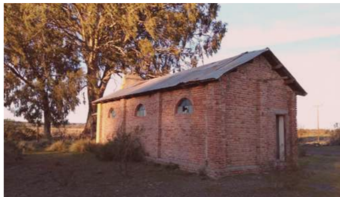
05 Capilla Primerxs pobladores de la isla chica (LMQ) 1935.- Construida con ladrillo macizo, madera y chapa, con una simple planta rectangular, se erige en la Isla Chica, siendo un punto de referencia e hito en la memoria colectiva del lugar.
