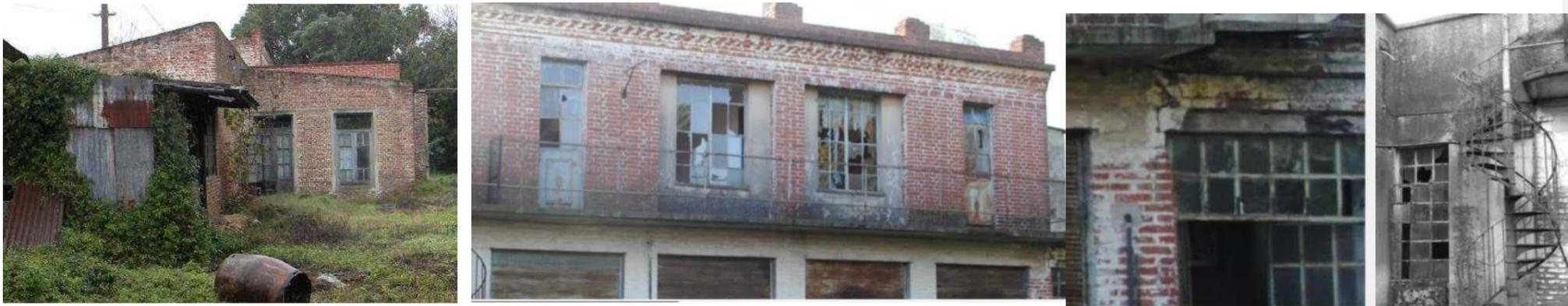
Casa del dueño De los tres edificios es el mas deteriorado ya que sufre un tremendo abandono( se encuentran pedazos de escombros), en sectores las cubiertas filtran agua la estructura principal esta en mal estado por sectores ,pero puede restaurarse las carpinterías pueden restaurarse y en algunos casos hay que remplazarlas
