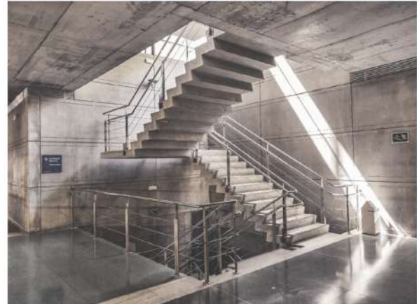
“Nucleo de escaleras iluminado naturalmente y artificialmente. Imagen de Autor. 201 .”
